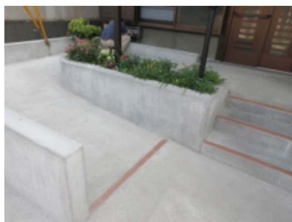
「階段とスロープ」段鼻や勾配がはじまるところには目印も忘れずに
