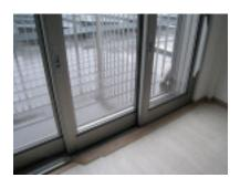
「車椅子の方が楽しむ屋上ガーデン」 出入口には開け閉めしやすく指かけを添えた三枚引き戸 と室内側にミニスロープを設置。
